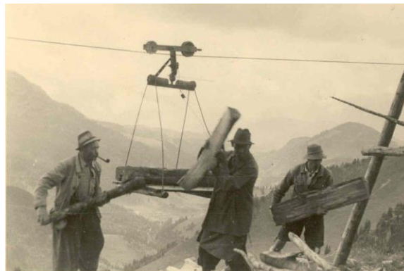
Legendär war die Brennholzseilbahn des langjährigen Wirtes der Hochrieshütte, Georg Seebacher. Sie führte bis 1967 vom Grozach, aus der Nähe der Holzerhütte, auf den Hochriesgipfel. Noch lange waren die primitiven Holzstützen zu sehen.
