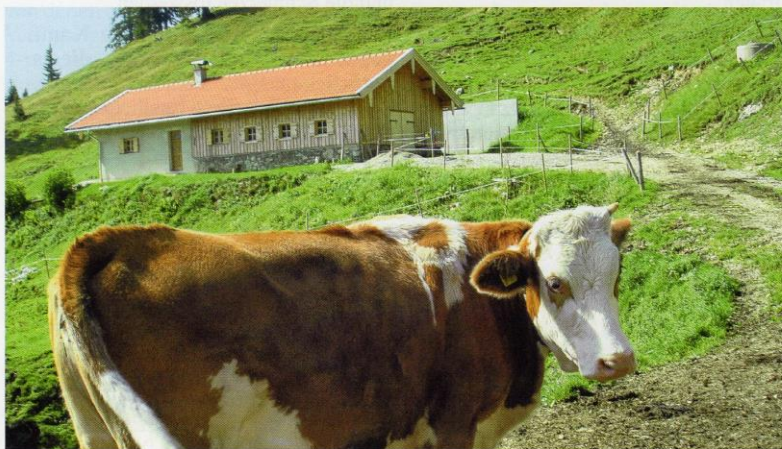
Der neue Kaser auf der Schoßrinnalm; rechts an der Hütte ist die Schutzwand aus Betonfertigteilen zu sehen.
